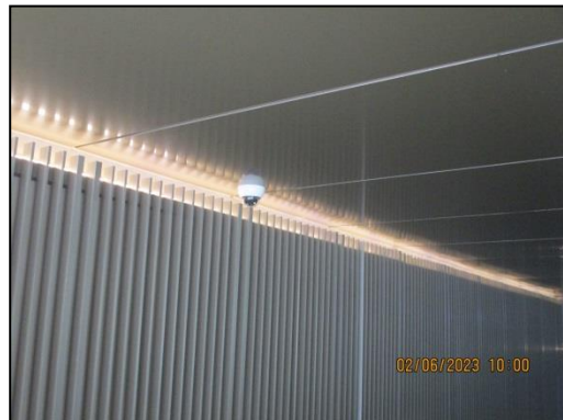
รูปที่ 26 ติดตั้งกล้องโทรทัศน์วงจรปิดในบริเวณภายในโครงการ
