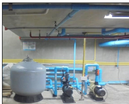
รูปที่ 12 ระบบรับน้ำจากการประปานครหลวงในโครงการ
