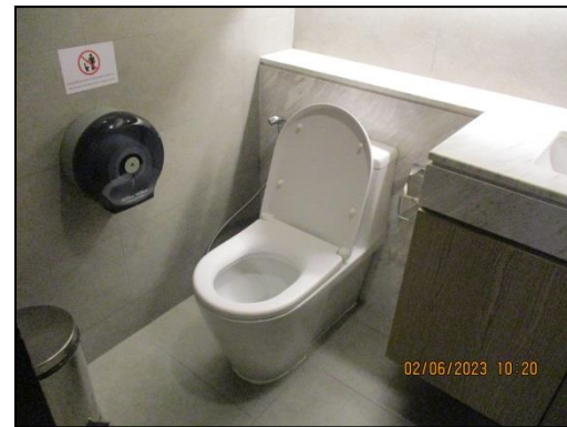
รูปที่ 11 เลือกใช้สุขภัณฑ์และอุปกรณ์แบบประหยัดน้ำในโครงการ
